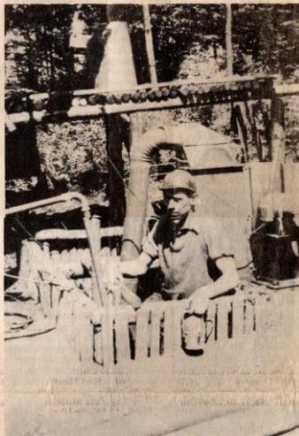
MIT WENIGEN TECHNISCHEN HILFSMITTELN mußten sich die Kumpel von einst begnügen: ein einfaches Frischluftgebläse (rechts im Bild), eine pumpegetriebene Grubenentwässerung (das Rohr ist links im Bild zu erkennen). Die als „Karbidfunzel“ bekannte Grubenlampe hält der Bergmann in der Hand. Die Kohle selbst wurde mit Eimern gefördert. Die Aufnahme entstand um 1950 an einem kleinen Schacht am Hasberg in Eppendorf.
