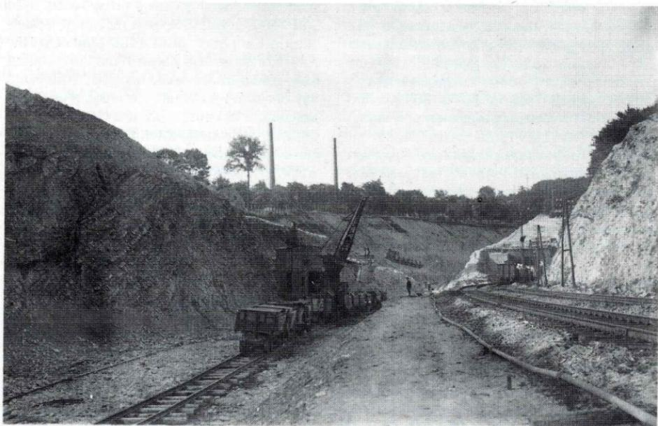
*Nachdem der 1870/71 erbaute Lengericher Eisenbahntunnel undicht geworden war, wurde in den zwanziger Jahren links neben dem alten ein neuer Tunnel erbaut, der Durchbruch für diesen erfolgte im Herbst 1927. Im alten Tunnel war während des 2. Weltkrieges ein Rüstungsbetrieb. (Aufnahme: Archiv Horst Grebing)*
