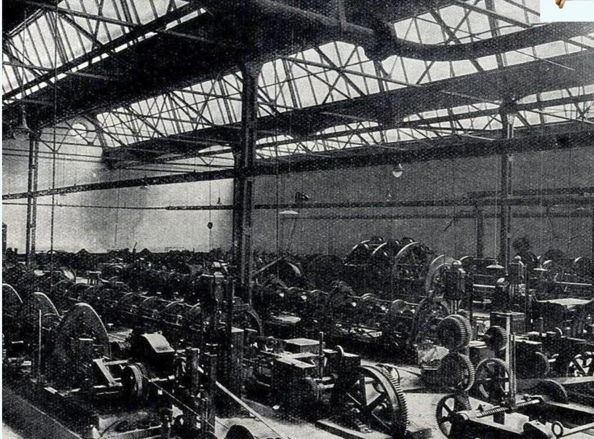
An den **Litzenmaschinen** werden die Drähte zu Litzen zusammengeflochten.
