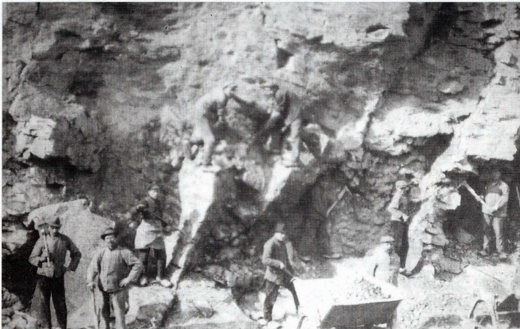
SPITZHACKE UND HAMMER waren auch um 1930 noch die einzigen Werkzeuge für den Kalksteinabbau. Vor Steinschlag schützten sich die Arbeiter nur mit Hüten oder Mützen. Erst nach dem Krieg wurde der Stein mittels Sprengung gebrochen.
