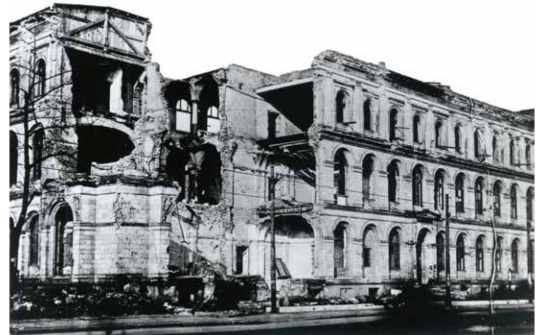
Abb. 2: Kriegsschäden an der Hauptfassade des Reichsamtes, um 1946. Archiv: Bundesanstalt für Geowissenschaften und Rohstoffe, Hannover
