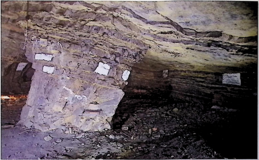
Abb. 1: Raum mit „Schiefer Säule“ zur natürlichen Abstützung der Firste. Foto: Horst Grebing, 2018
